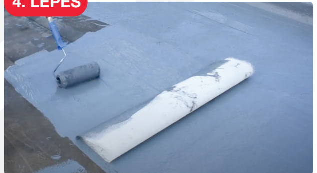
Az első réteg STARFLEX bevonatszigetelés felhordása
