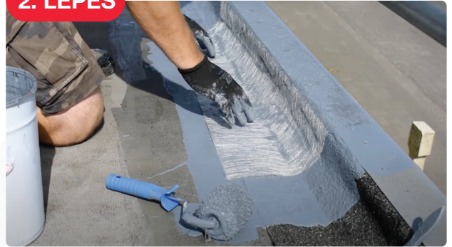
A szegélyek és részletek megerősítése STARFLEX -el és STARTEX NW DETAILS -el.
