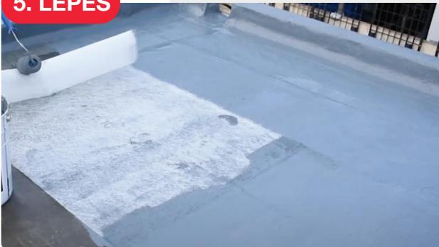
A STARTEX erősítő szövet beépítése.
