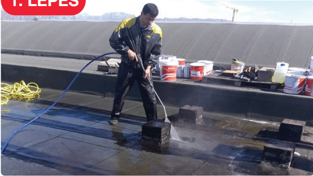
Az aljzat megtisztítása és előkészítése.
