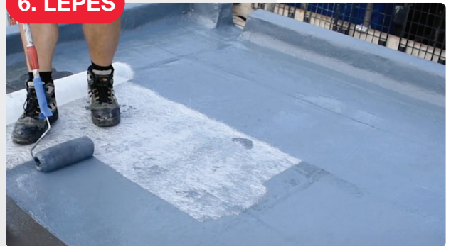
Az második réteg STARFLEX bevonatszigetelés beépítése nedves a nedvesre eljárással.
